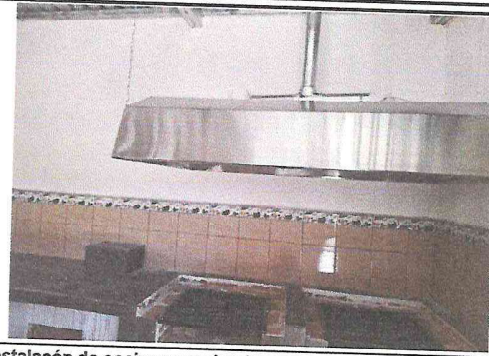
Foto 2: Instalación de cocina y sus implementos
