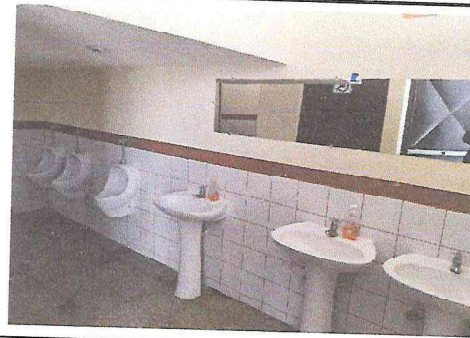
Foto 4: reparación de migntorio
