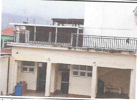
Foto 1: Reestructuración de cocina funcional
