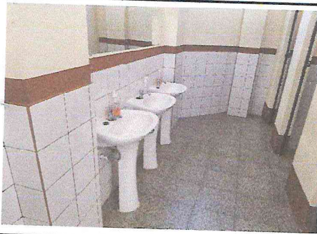
Foto 3: reparación de lavamanos
