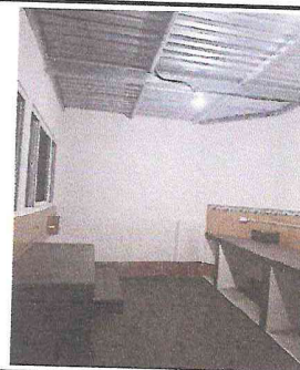
Foto 6: Cnstrucción de gabnetes para cocina
